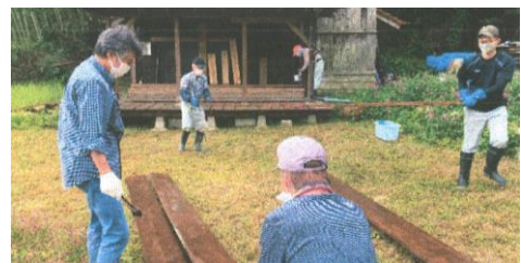
蔵の床材に防腐剤を塗布
