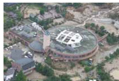
防府市真尾・土石流被害(平成21年)
